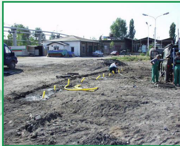
12.sz. ábra: furatok feltöltése enzimmel
