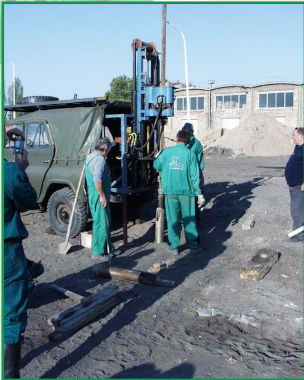
9 sz. ábra: kezelőfuratok készítése
