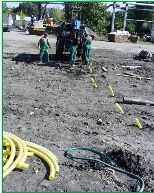
10 sz. ábra: perforált gégecsövek lehelyezése
