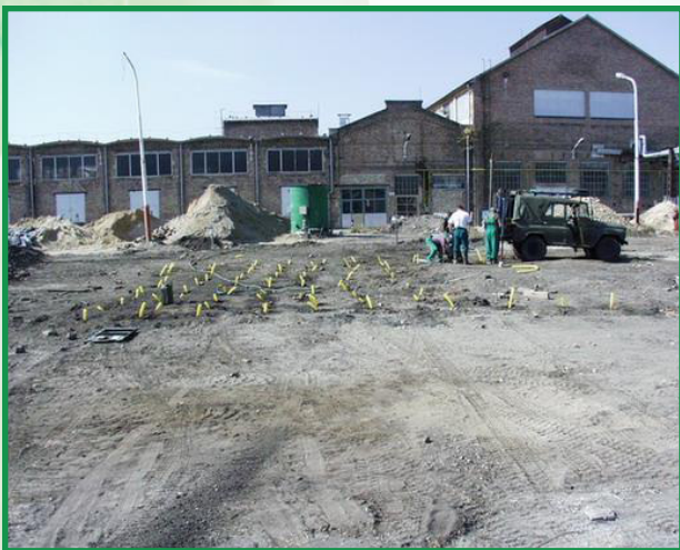
13.sz. ábra: furatok feltöltése enzimmel
