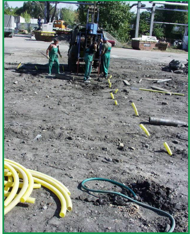
Ablegung von perforierten Faltenschläuchen
